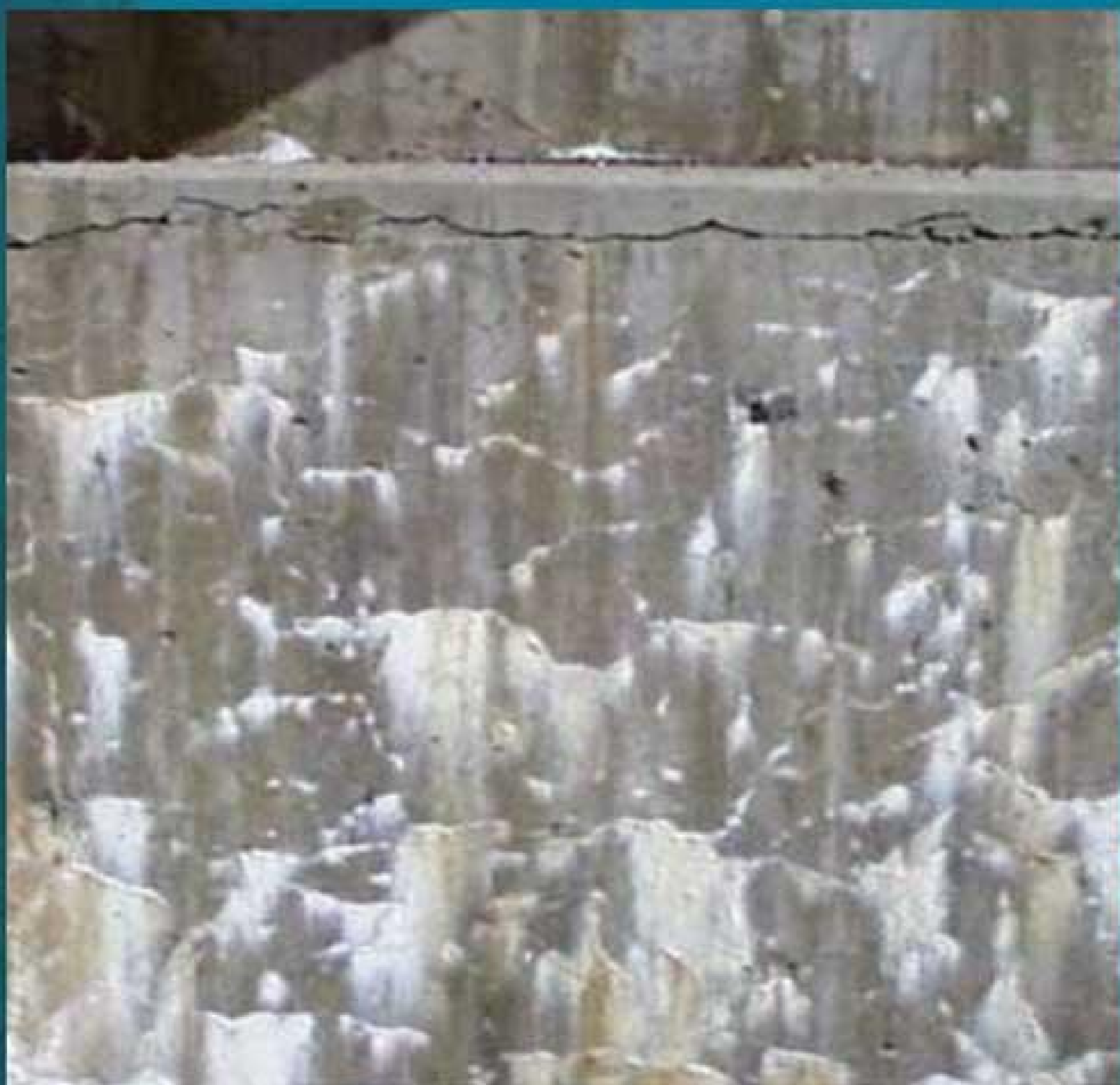
(۵) ژل تشکیل شده رطوبت و آب جذب کرده، منبسط شده و فشار اسمزی به خمیر احاطه کننده یا سنگدانه وارد می کند.
